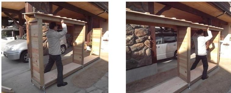
⑩ 屋根パネル同志を連結してください。65mmビスで片側3本ずつ計6本で引っ張り合います。床パネル連結と同じイメージです。
