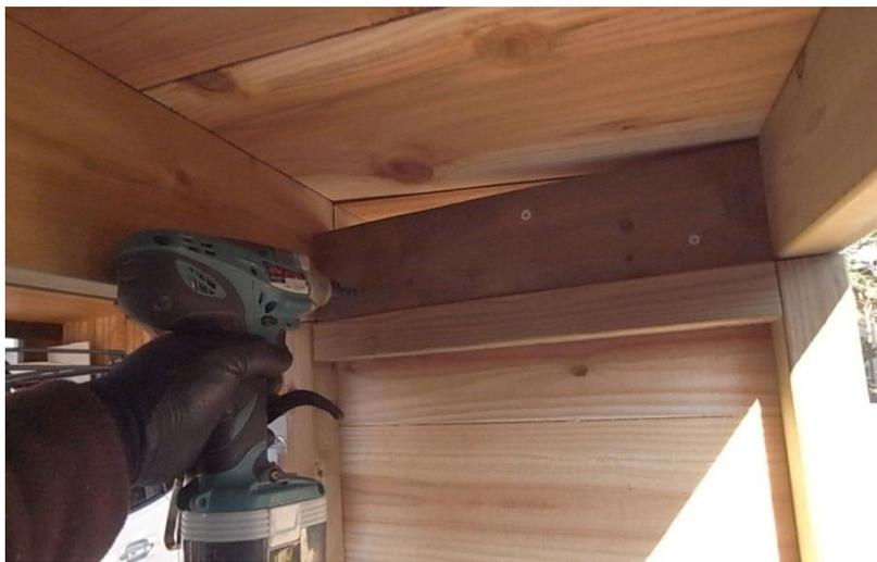
⑪ 屋根パネルと左右の壁パネルを下図のように揃えます。
