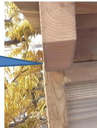
⑫ 床一壁パネルと同様に75mmビスで外側 3本垂直、内側も3本ビス固定します。
